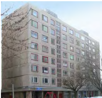
Az északi és keleti homlokzat felújítás előtt
