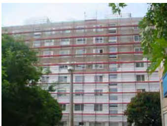
Az állványozás, és a szigetelés folyamata
