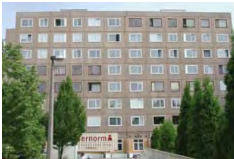
Az északi homlokzat részleges ablakcserével
