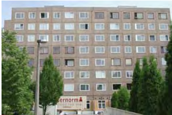
Az északi homlokzat részleges ablakcserével
