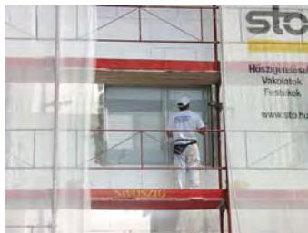
A homlokzati fal hőszigetelése
