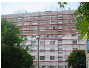
Az állványozás, és a szigetelés folyamata
