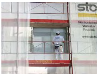
A homlokzati fal hőszigetelése
