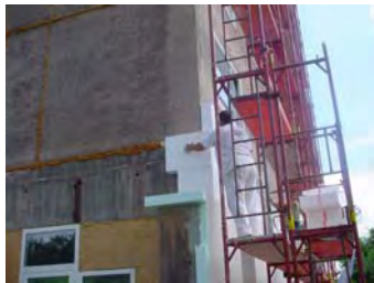
Indul a lakószinti hőszigetelés
