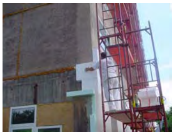
Indul a lakószintű hőszigetelés
