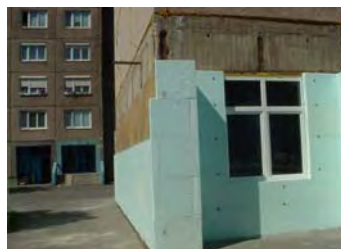
Hőszigetelő lemezek a déli földszinti homlokzaton, valamint a végfalon
