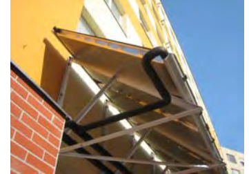
Előtetőként funkcionáló napkollektorok
