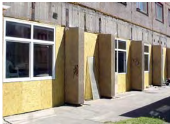
Az új földszinti fal a hőszigetelés előtt
