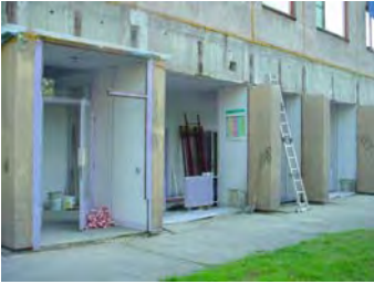
A földszinti nyílászárók bontása
