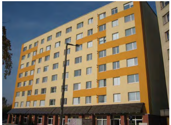
A felújított déli homlokzat a napkollektor mezővel
