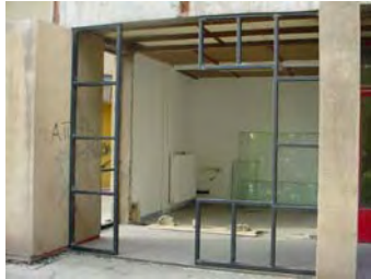
Zártszelvény acél szerkezet a falnyílásban
