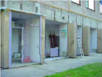
A földszinti nyílászárók bontása
