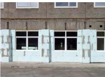
Hőszigetelő lemezek a déli földszinti homlokzaton, valamint a végfalon
