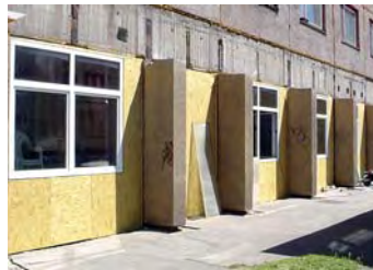
Az új földszinti fal a hőszigetelés előtt
