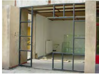
Zártszelvény acél szerkezet a falnyílásban
