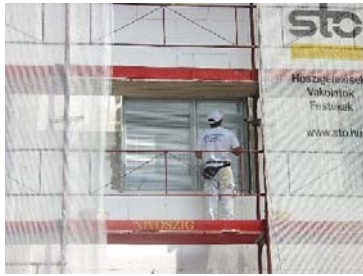
4. ábra Homlokzat hőszigetelése
