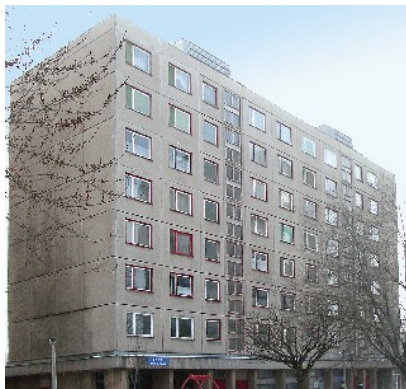
1. ábra A SOLANOVA épület a felújítás előtt
