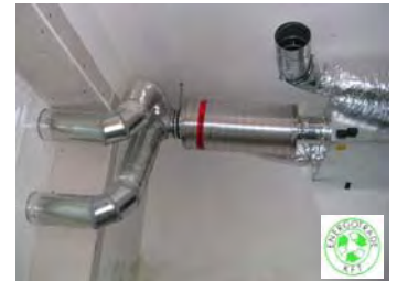
A konyhai elszívás kialakítása (burkolat nélkül)
