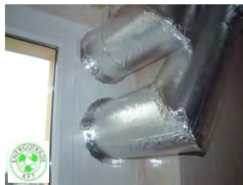
A légtechnikai csővezetékek ablakkereten való kivezetése (burkolat nélkül)
