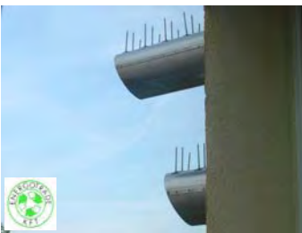
A homlokzati beszívó és kifúvó csanakok
