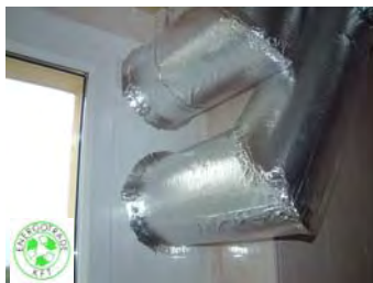
A légtechnikai csővezetékek ablakkereten való kivezetése (burkolat nélkül)
