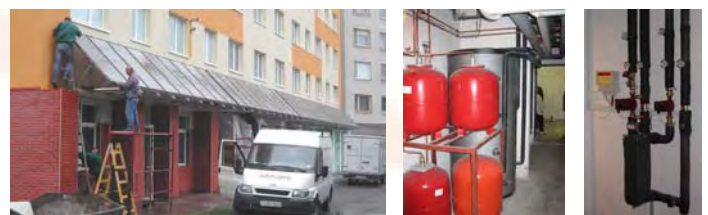
A kollektorok szerelése és a gépészeti berendezések
