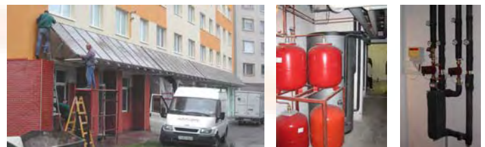
A kollektorok szerelése és a gépészeti berendezések
