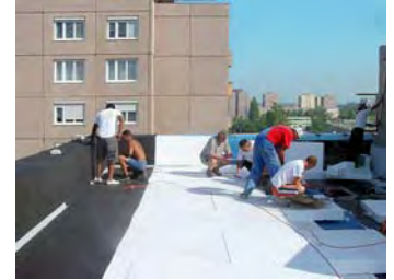
Az AUSTROTHERM hőszigetelő táblák fektetése
