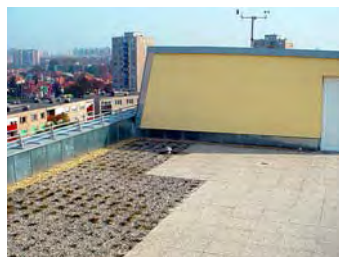
A felújított tető részlete
