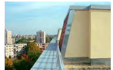
A felújított tető részlete
