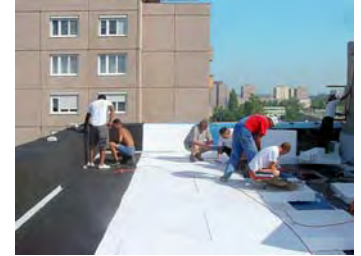
Az AUSTROTHERM hőszigetelő táblák fektetése
