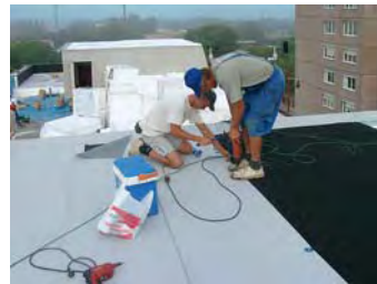
A liftgépház csapadékvíz-szigetelésének készítése
