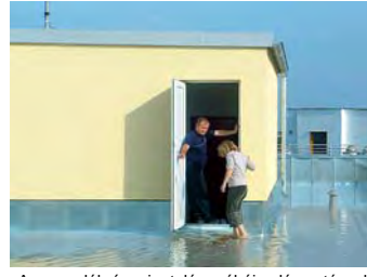
A csapadékvíz szigetelés próbája elárasztással
