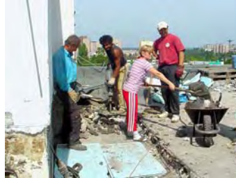
A régi tetőszigetelő rétegek bontása
