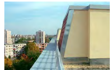
A felújított tető részlete
