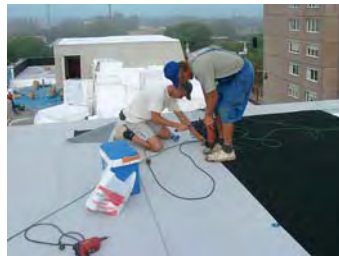
A liftgépház csapadékvíz-szigetelésének készítése
