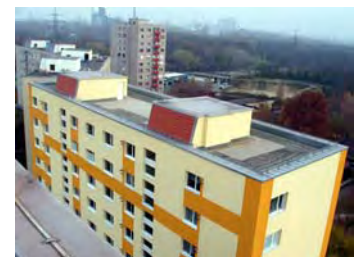
A felújított tető madártávlatból
