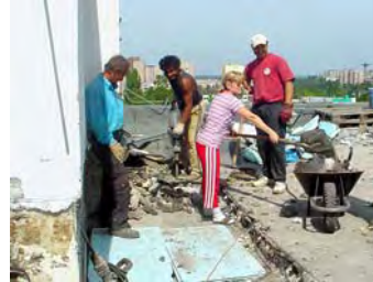
A régi tetőszigetelő rétegek bontása
