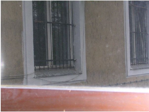
38. ábra Az épület nyílászárója
