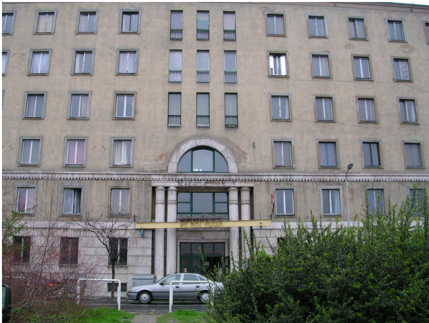
37. ábra A kollégium homlokzata
